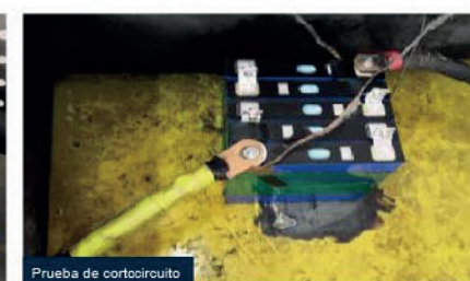
Prueba de cortocircuito
